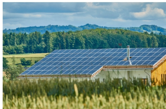
Installation de panneaux solaires
