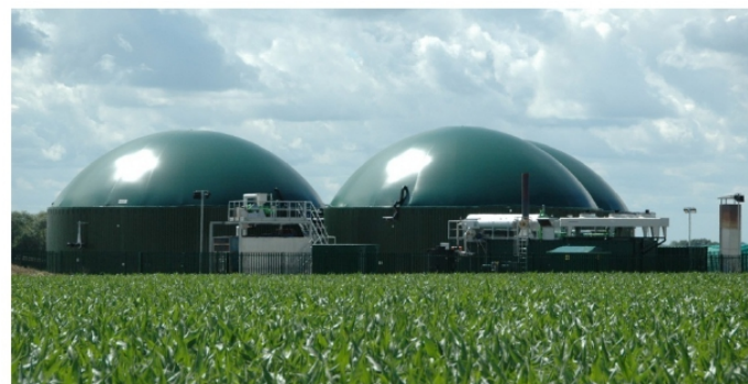
Installation de méthaniseurs
